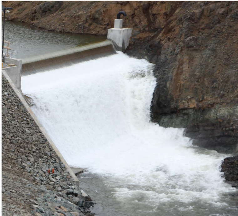
Mynd 2.1 Ljósmynd af flóðvirki sambærilegu því sem áætlað er að nota í Skjálfandafljóti við inntak Einbúavirkjunar.
